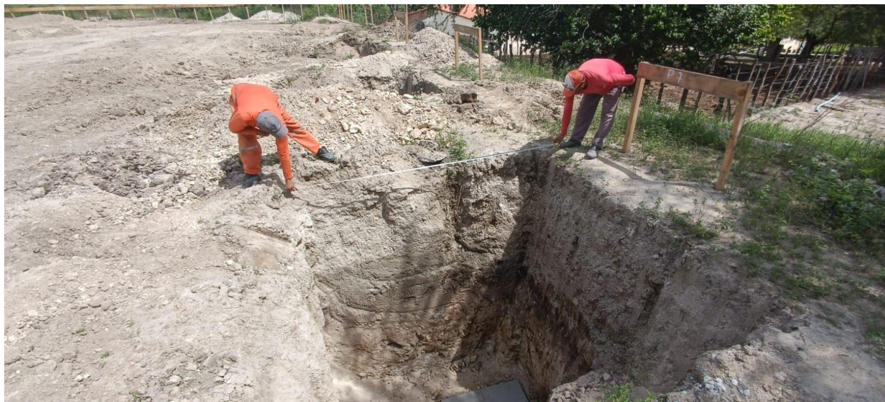
Figura 1: Escavação para blocos de fundação.
