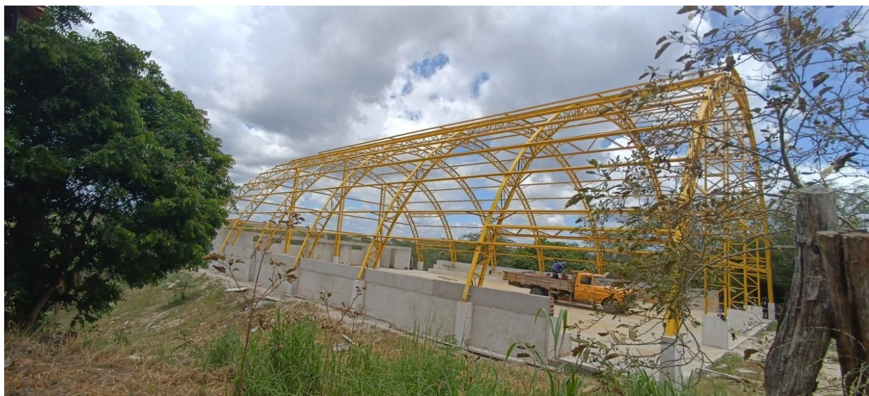
Figura 3: Estrutura metálica da coberta.
