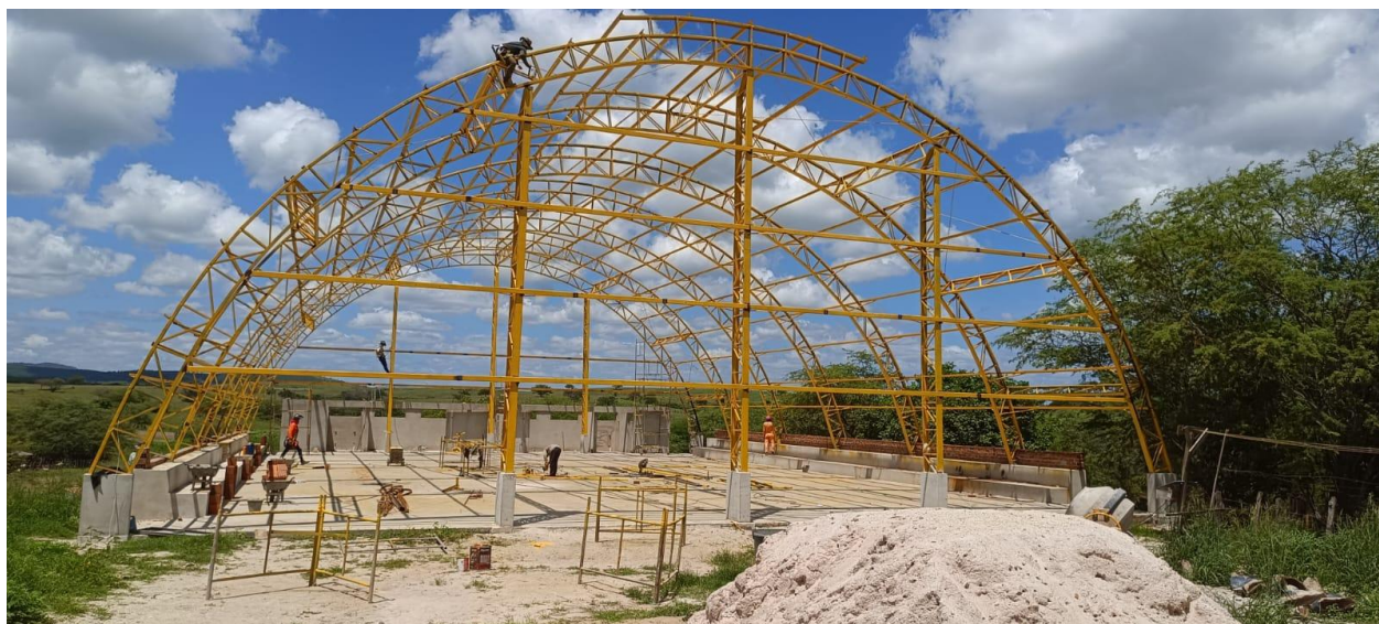
Figura 2: Montagem da estrutura metalica da coberta.
