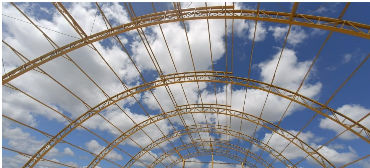
Figura 6: Estrutura metálica da coberta.
