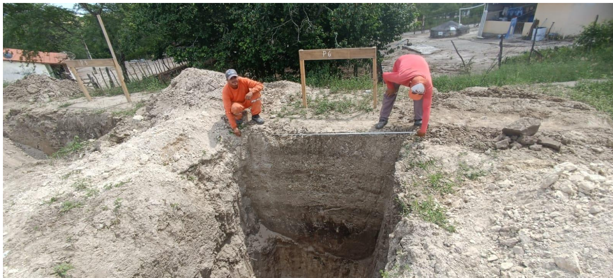
Figura 2: Escavação para blocos de fundação.
