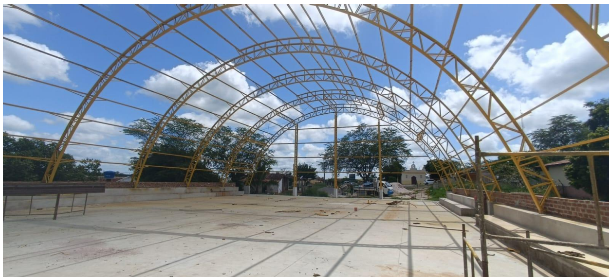
Figura 5: Estrutura metálica da coberta.
