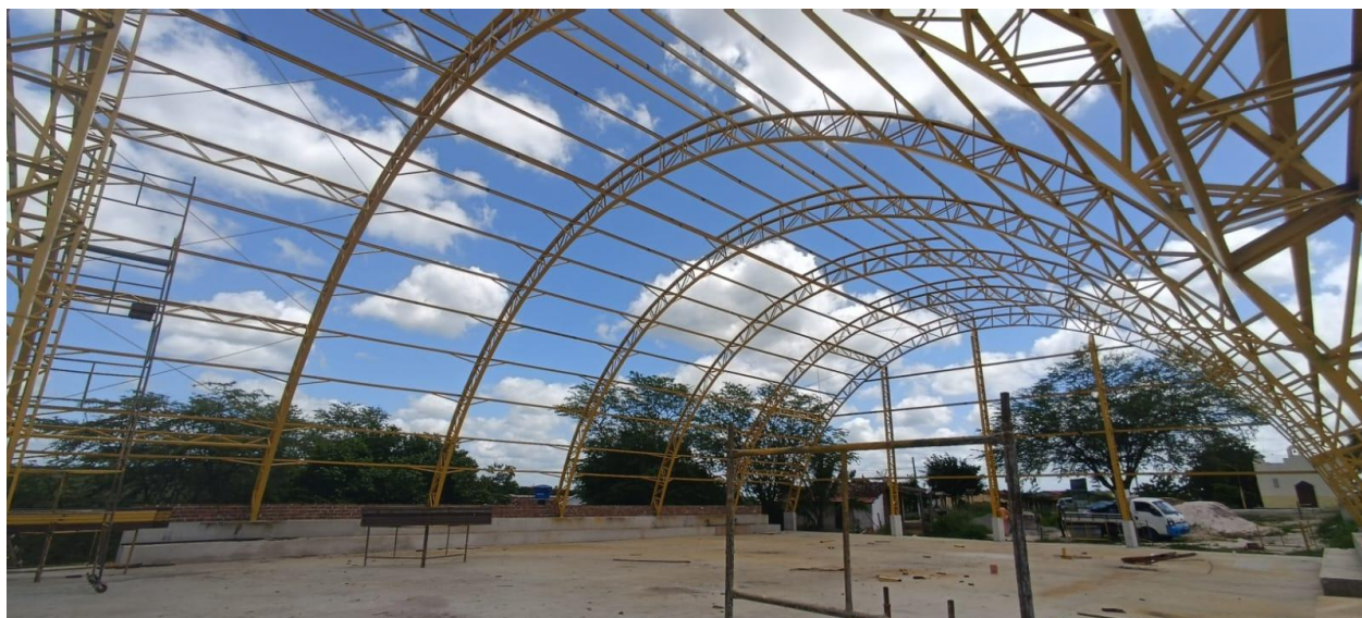
Figura 7: Estrutura metálica da cobertura.
