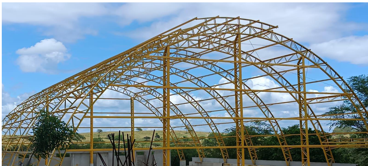
Figura 8: Estrutura metálica da cobertura.
