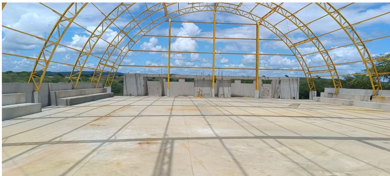
Figura 4: Estrutura metálica da coberta.
