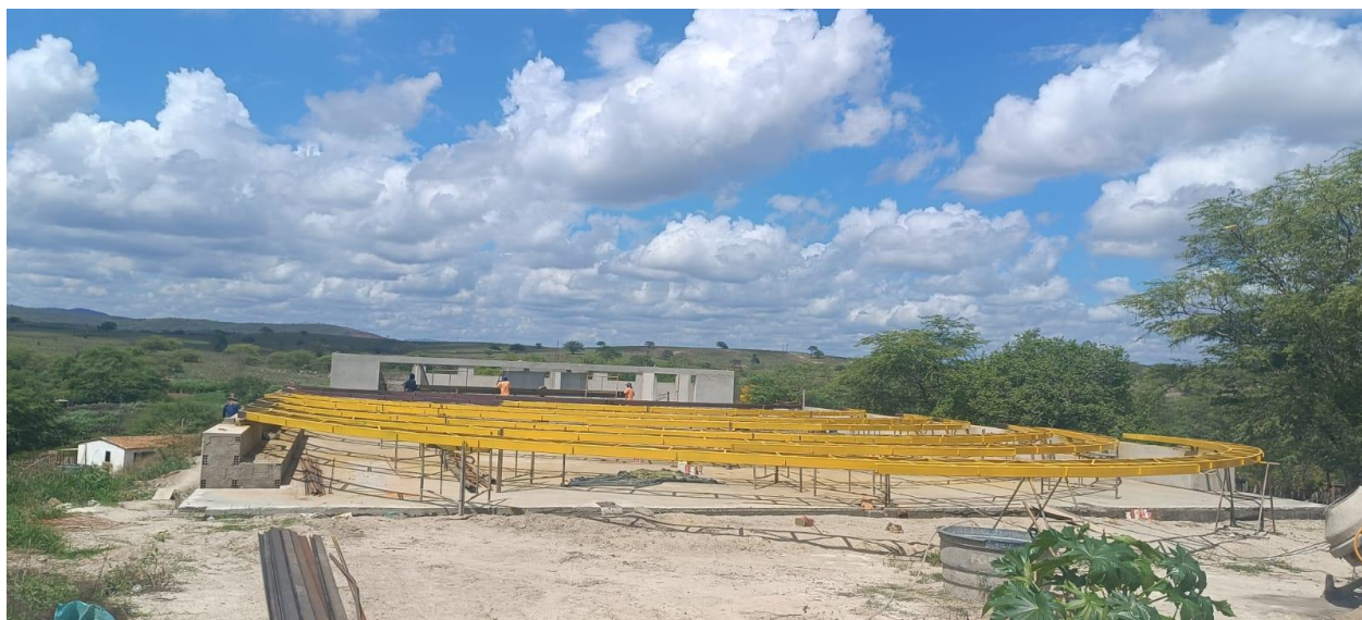
Figura 1: Pintura da estrutura metalica da coberta.
