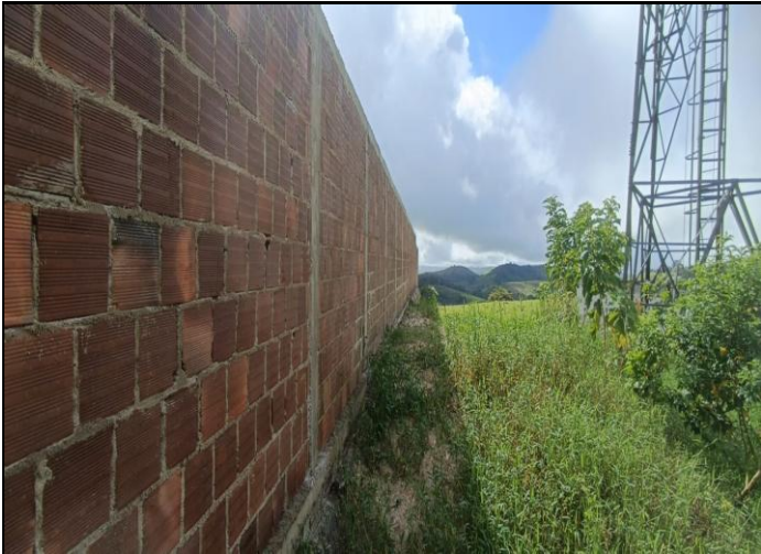
FOTO 07 EXECUÇÃO DE MURO PILARES, CINTA DE AMARRAÇÃO
