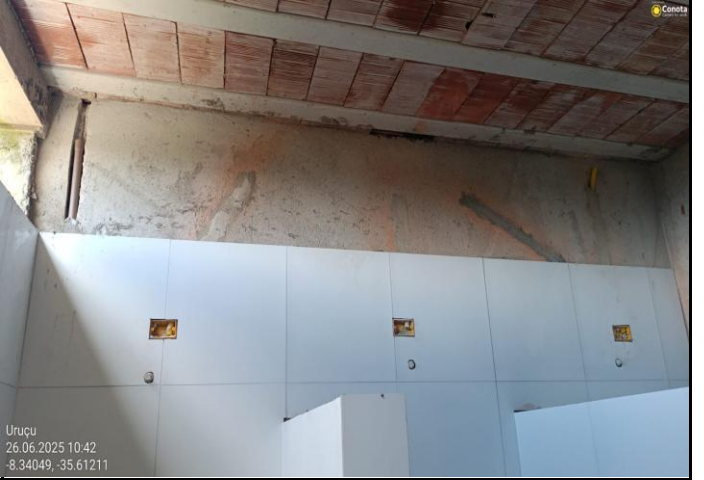
FOTO 10 EXECUÇÃO DAS CAIXAS DE ELETRICAS
