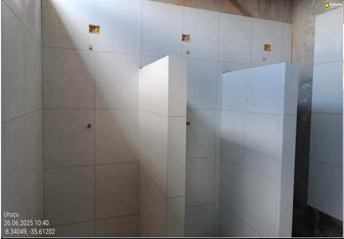
FOTO 09 EXECUÇÃO DAS CAIXAS DE ELETRICAS
