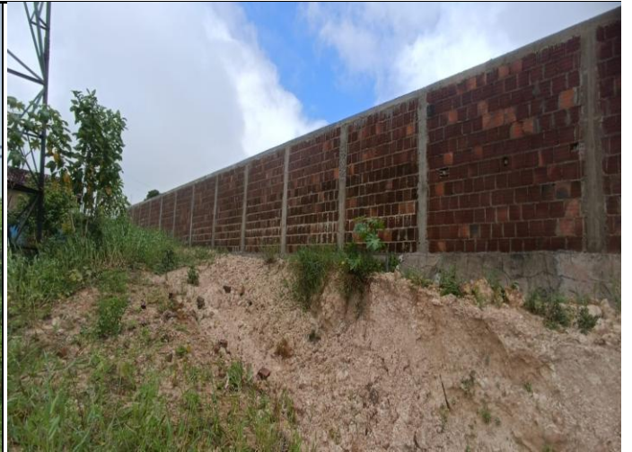
FOTO 08 EXECUÇÃO DE MURO PILARES, CINTA DE AMARRAÇÃO
