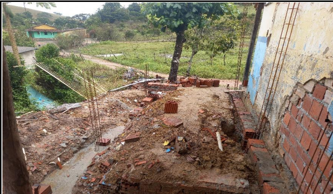
Foto 02: Demolição do antigo banheiro.
