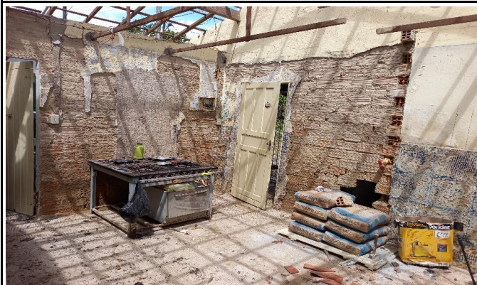
Foto 01: Demolição de alvenaria da cozinha.
