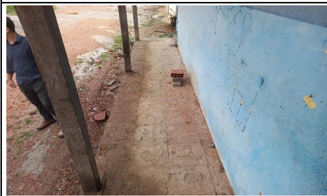
Foto 05: Demolição de revestimento ceramico do piso da calçada.
