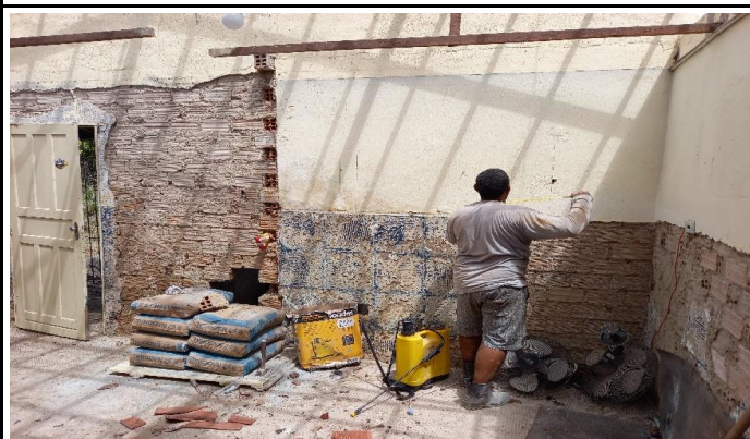
Foto 06: Demolição de revestimento ceramico das paredes da cozinha e hall.
