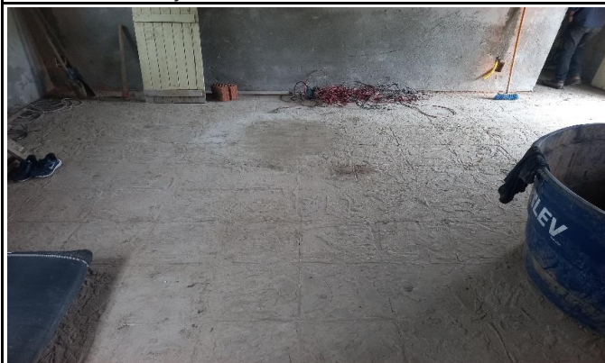
Foto 03: Demolição de revestimento ceramico do piso da sala de aula.
