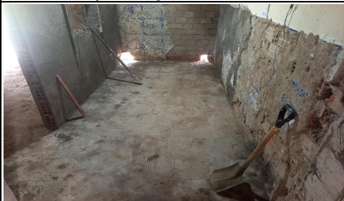
Foto 04: Demolição do revestimento ceramico do piso do hall.
