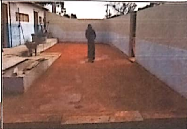
FOTO 02: Aterro do patio.
