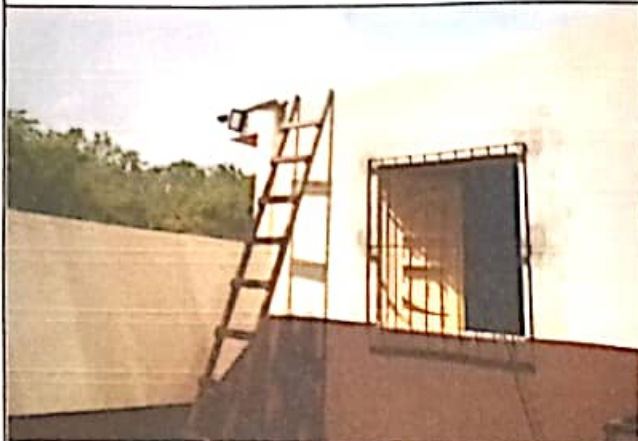
FOTO 01: Janela da cozinha, nova posição
