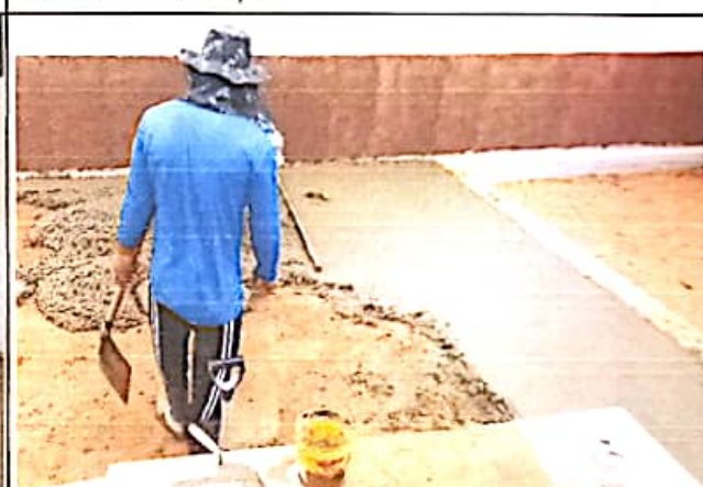
FOTO 04: Piso cimentado do patio.
