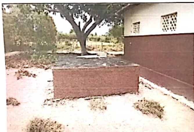
FOTO 07: Pintura do reservatório.
