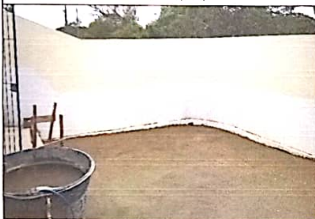
FOTO 03: Piso cimentado do patio.
