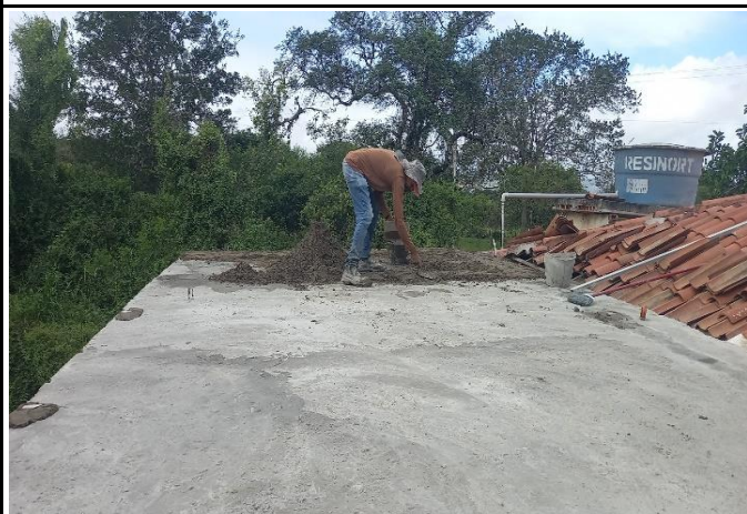
FOTO 12: Laje pré moldada da cozinha.
