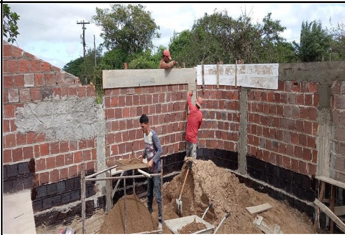
FOTO 02: Alvenaria de vedação do muro frontal da escola.
