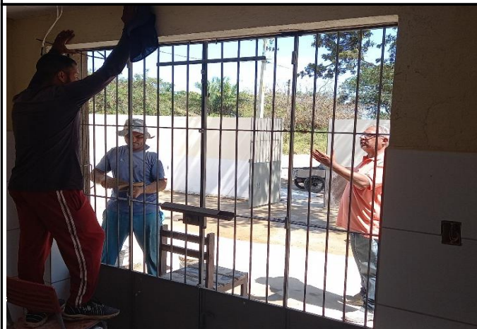
FOTO 07: Portão de acesso aos banheiros.
