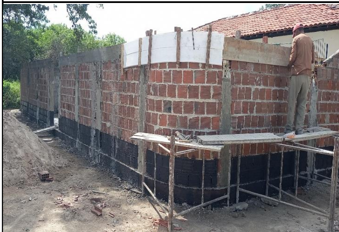
FOTO 01: Impermeabilização do muro de frontal da escola.
