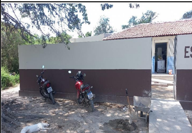
FOTO 10: Pintura em tinta latex.
