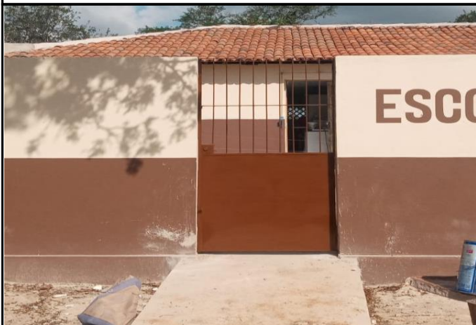
FOTO 13: Portão de ferro de acesso principal.
