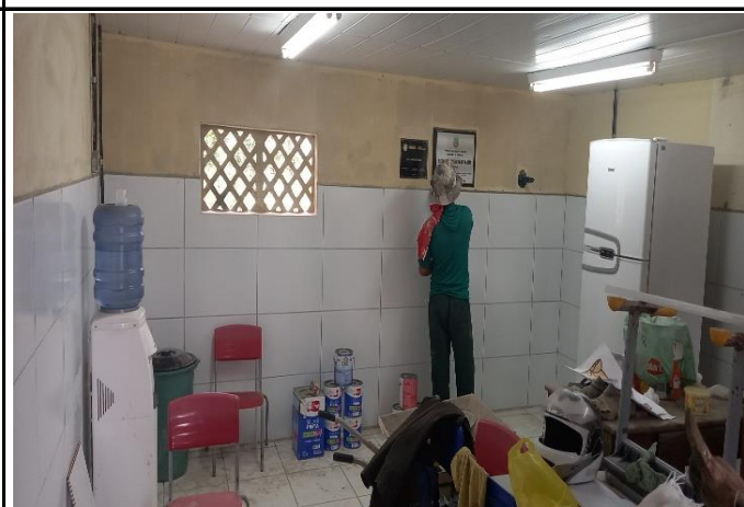
FOTO 04: Revestimento cerâmico nas sala de aula.
