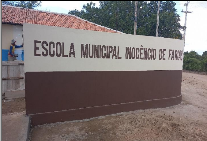
FOTO 09: Abertura de letreiro na fachada da escola.
