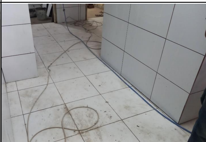
FOTO 06: Revestimento cerâmico do piso da circulação dos banheiros.
