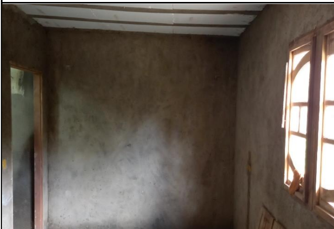
FOTO 03: Emboço da área interna da cozinha.
