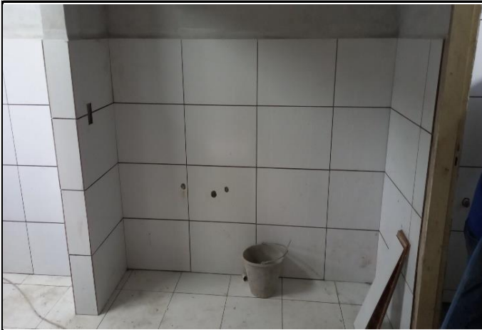
FOTO 07: Revestimento cerâmico das paredes da circulação dos banheiros.
