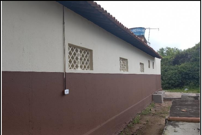
FOTO 10: Pintura da área externa da escola.
