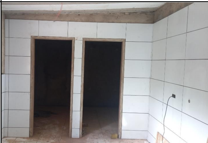
FOTO 04: Revestimento cerâmico das paredes da cozinha.
