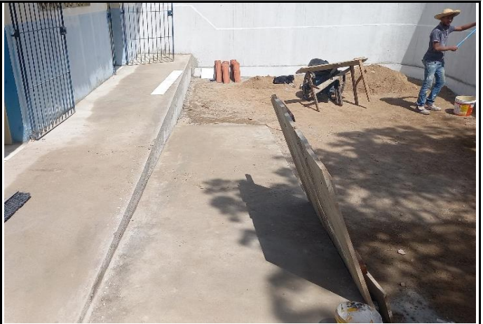
FOTO 08: Execução de piso da rampa de acesso a escola.
