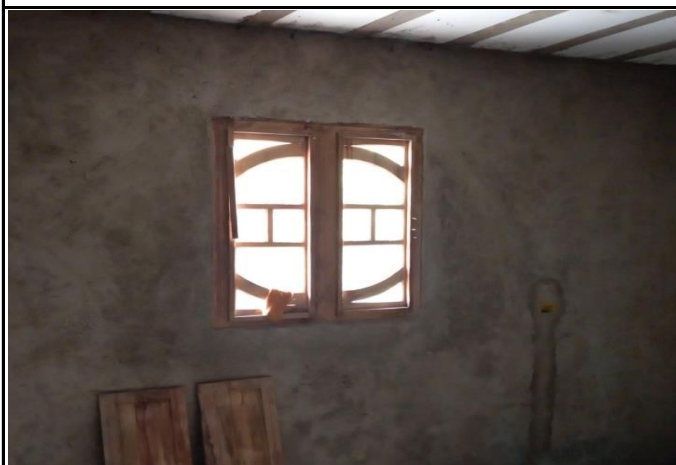
FOTO 05: Janela da cozinha.
