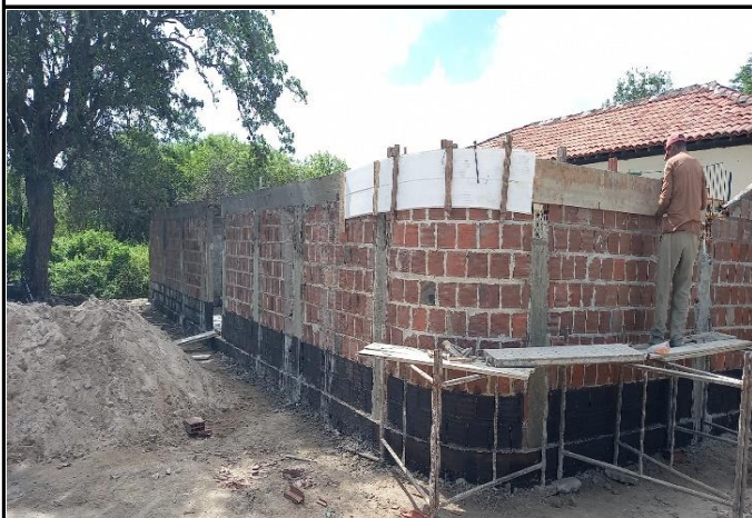
FOTO 01: Alvenaria do muro frontal.
