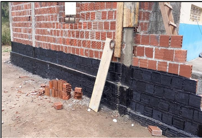
FOTO 07: Impermeabilização do embassamento da cozinha.
