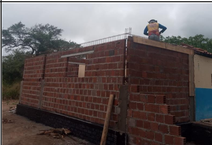
FOTO 04: Alvenaria de vedação da cozinha.
