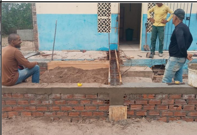
FOTO 02: Alvenaria de embassamento da cozinha.
