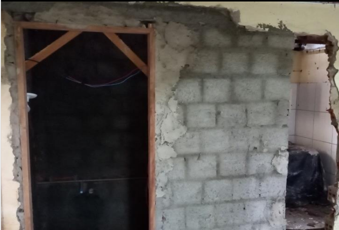
FOTO 09: Chapisco da alvenaria de vedação do banheiro novo.
