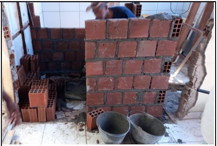
FOTO 08: Alvenaria de vedação do banheiro novo.
