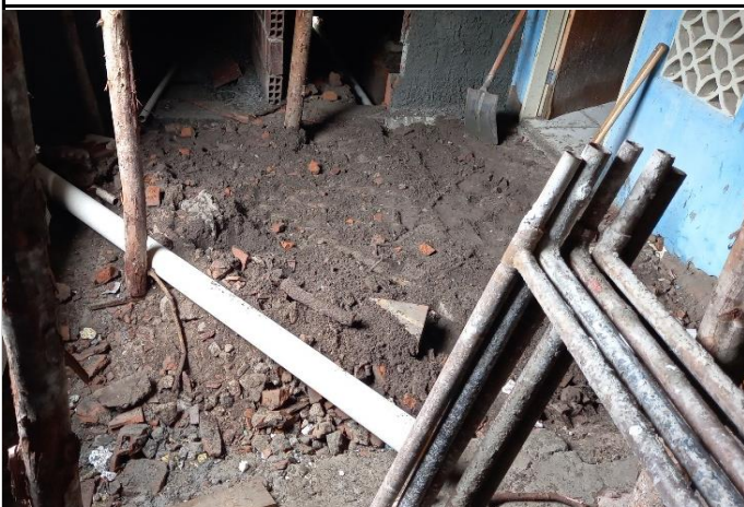
FOTO 05: Aterro do embassamento da cozinha.
