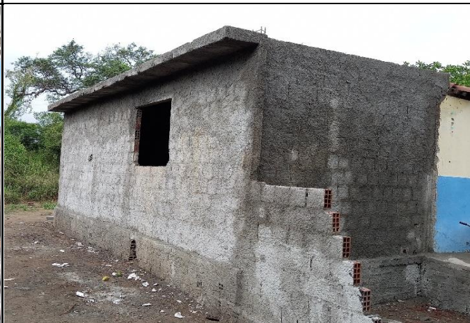
FOTO 06: Chapisco da alvenaria de vedação da cozinha.
