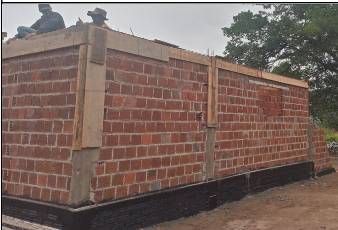
FOTO 03: Pilares de concreto armado da cozinha.
