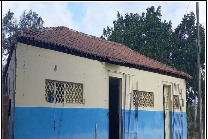
FOTO 10: Revisão de cobertura de toda escola.
