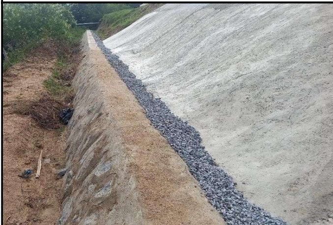
FOTO 01: Muro de arrimo.
