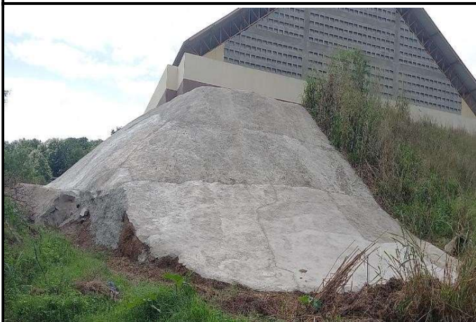
FOTO 05: Concreto projetado no talude.
