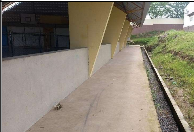
FOTO 07: Execução de calçada externa da quadra.
