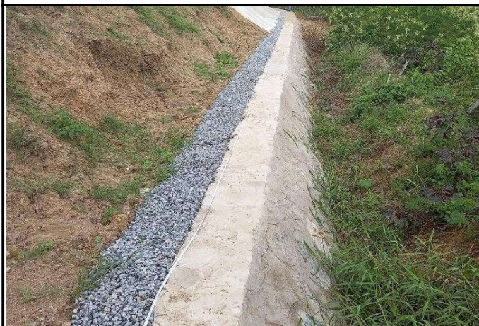
FOTO 03: Muro de arrimo.
