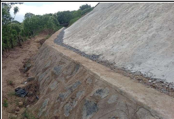
FOTO 02: Muro de arrimo.
