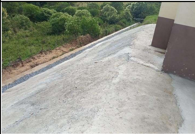
FOTO 06: Concreto projetado no talude.
