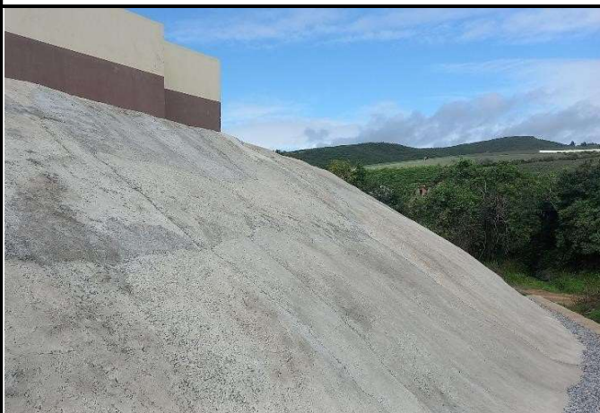
FOTO 04: Concreto projetado no talude.
