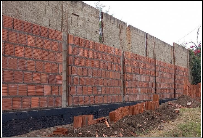
FOTO 02: Armação de pilares.
