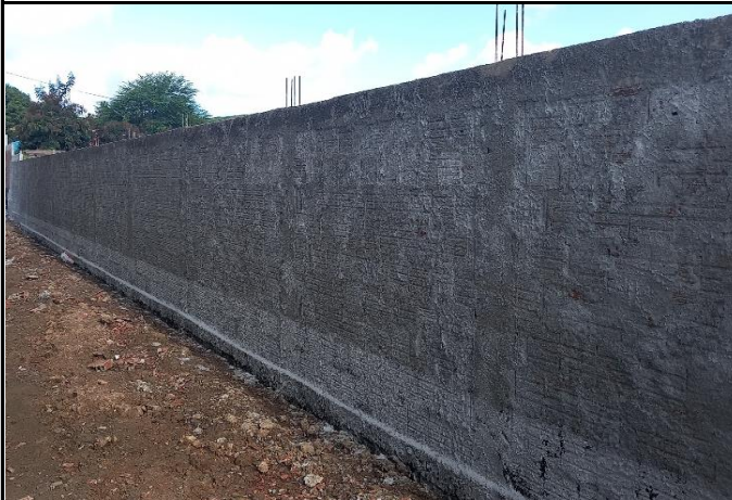
FOTO 05: Chapisco na alvenaria de vedação.
