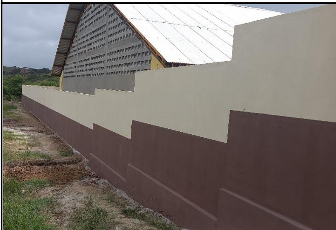
FOTO 07: Pintura do muro com tinta acrílica.
