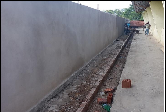
FOTO 06: Reboco no murro do fundo.
