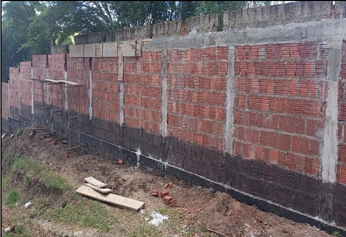
FOTO 03: Concretagem dos pilares.
