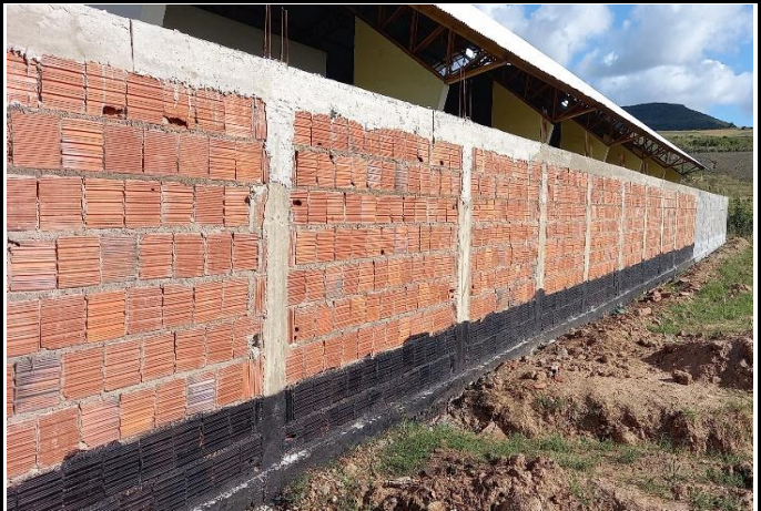
FOTO 04: Alvenaria de vedação.
