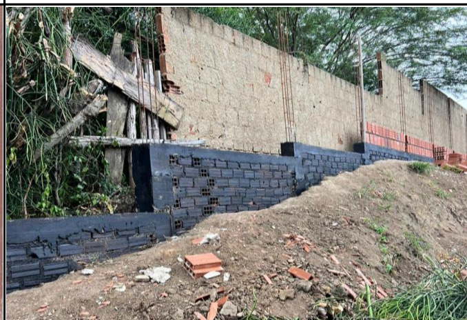
FOTO 12: Alvenaria de embassamento.
