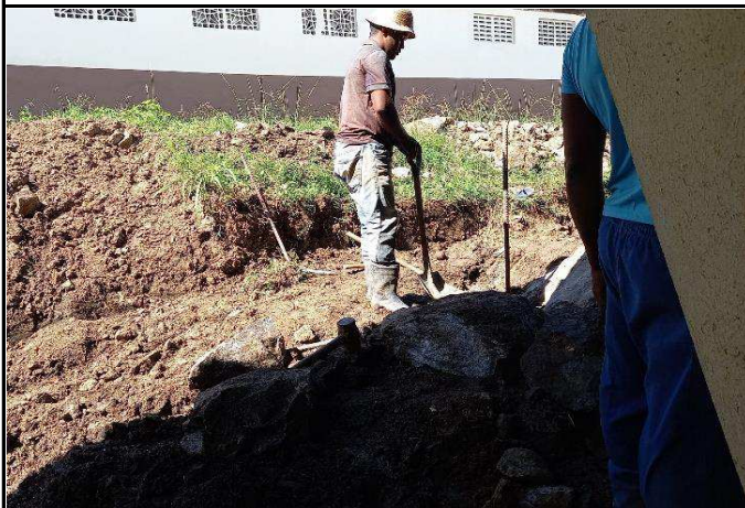
FOTO 01: Desmonte de pedra.
