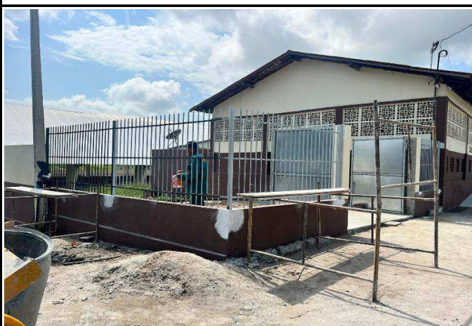
FOTO 06: Gradil do muro de contorno.
