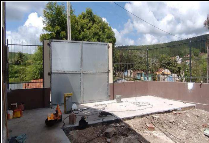
FOTO 07: Portão de acesso a quadra.
