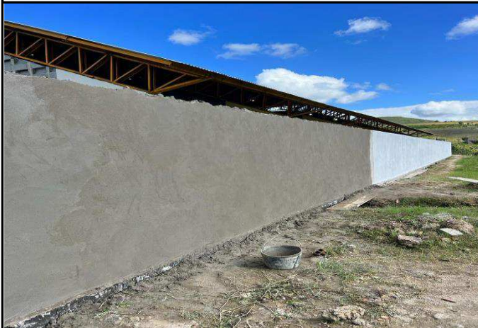
FOTO 03: Massa única no muro de contorno.
