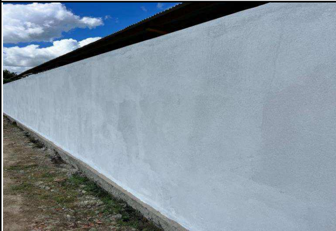
FOTO 04: Aplicação de selador no muro de contorno.
