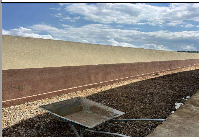
FOTO 05: Pintura com tinta acrílica no muro de contorno.
