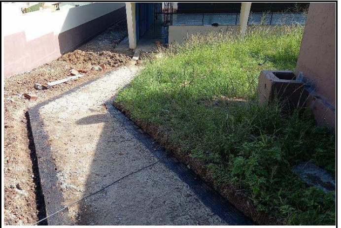
FOTO 08: Impermeabilização do passeio da quadra.
