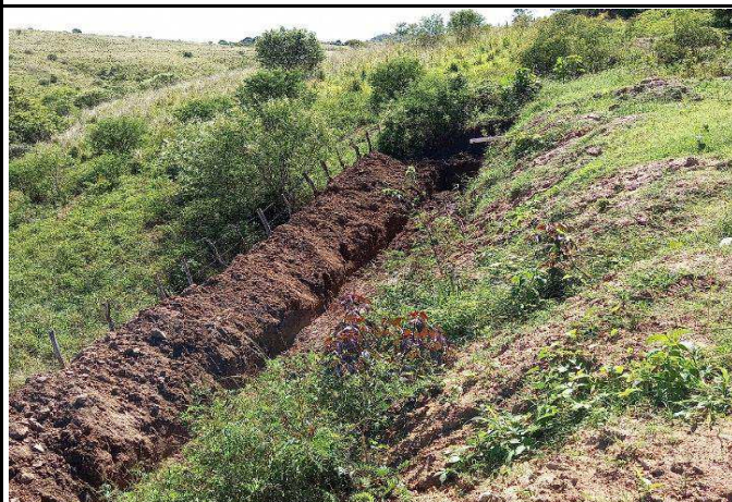
FOTO 02: Escavação do muro de contenção da quadra.
