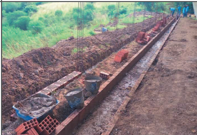
FOTO 04: Canaleta de drenagem lateral da quadra.
