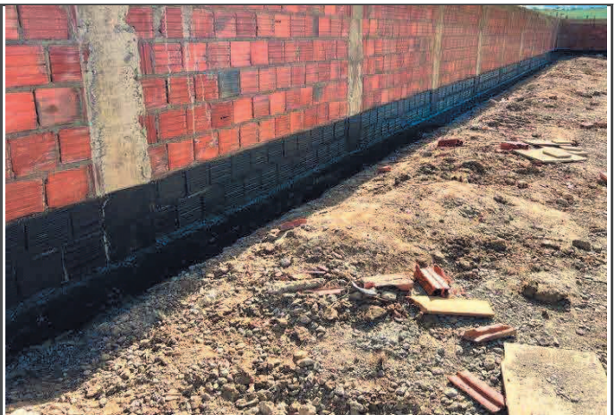
FOTO 08: Impermeabilização do muro de contorno.
