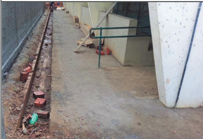
FOTO 03: Execução de passei lateral da quadra.
