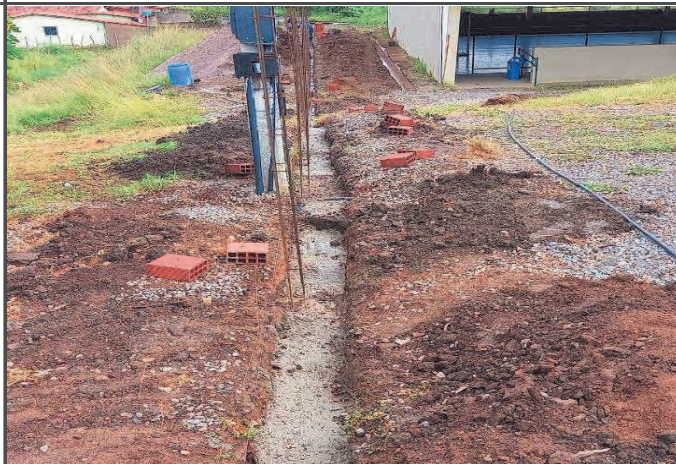
FOTO 02: Lastro de concreto magro.
