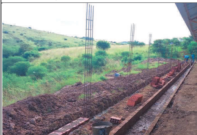
FOTO 05: Armação de aço 8mm para pilares.
