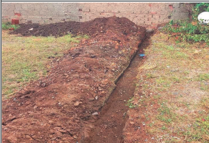
FOTO 01: Escavação para execução de embasamento.
