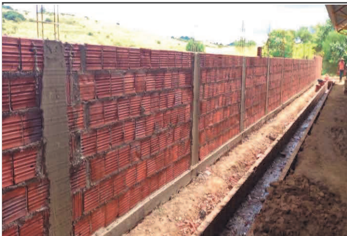
FOTO 07: Alvenaria de vedação.
