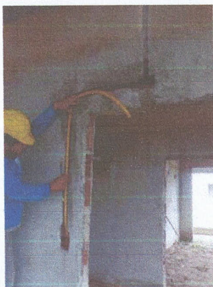
IMAGEM 01: Colocação dos Eletrodutos
