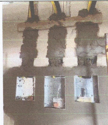
IMAGEM 08: Instalação de eletrodutos e quadro elétrico
