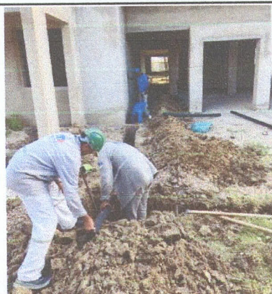
IMAGEM 09: Instalação de eletrodutos
