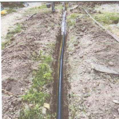
IMAGEM 05: Passagem de tubulação
