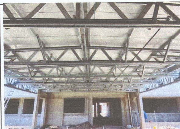
IMAGEM 12: Instalação de eletrocalha
