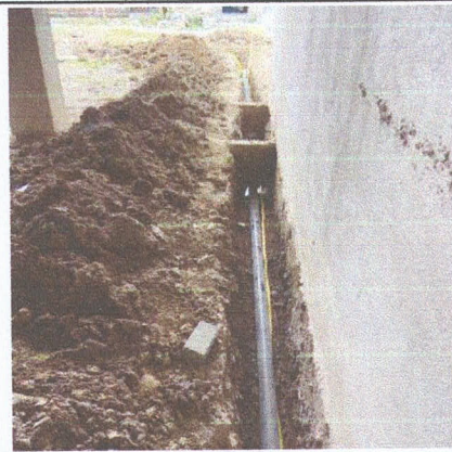
IMAGEM 06: Passagem de tubulação
