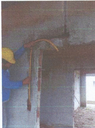
IMAGEM 01: Colocação dos Eletrodutos
