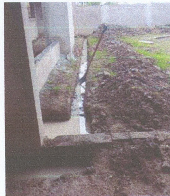
IMAGEM 04: Escavação para a passagem da tubulação
