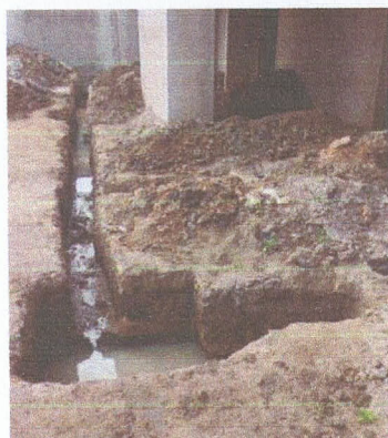
IMAGEM 03: Escavação para a passagem da tubulação
