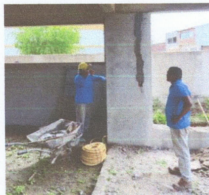
IMAGEM 02: Colocação dos Eletrodutos
