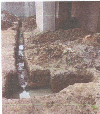
IMAGEM 03: Escavação para a passagem da tubulação
