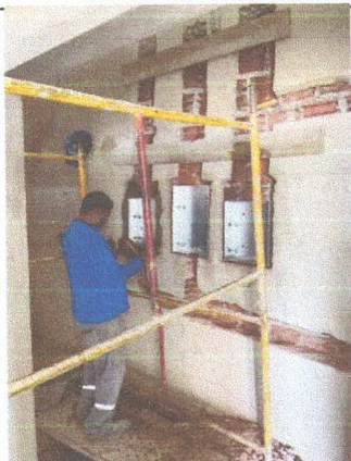
IMAGEM 07: instalação de quadro elétrico
