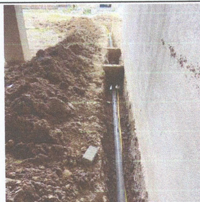
IMAGEM 06: Passagem de tubulação
