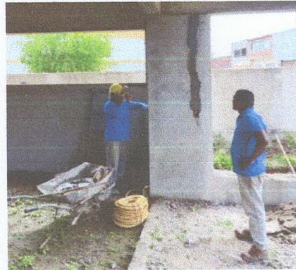
IMAGEM 02: Colocação dos Eletrodutos
