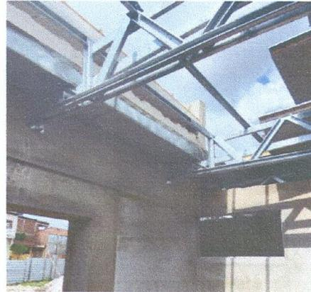
IMAGEM 08: Instalação das Calhas
