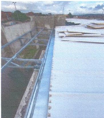
IMAGEM 09: Instalação das Calhas
