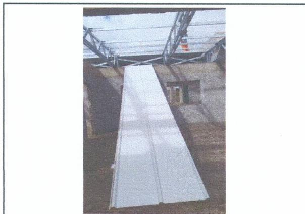
IMAGEM 04: Instalação das telhas
