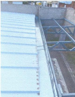
IMAGEM 11: Instalação das Calhas
