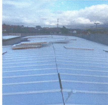
IMAGEM 10: Instalação das telhas
