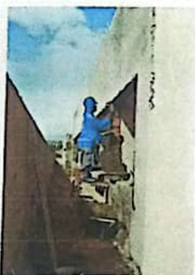
IMAGEM 05: Execução de reboco e emboço
