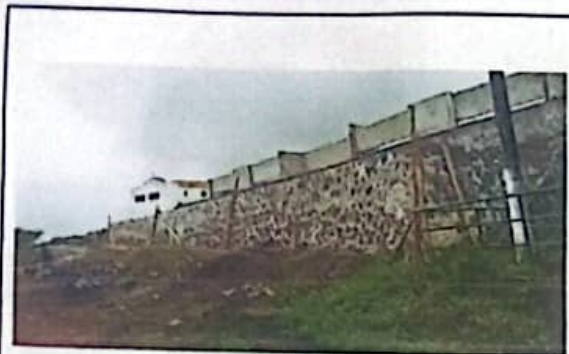
IMAGEM 01: Execução do Muro de arrimo
