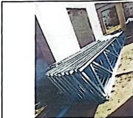
IMAGEM 10: Execução de reboco e emboço e material da estrutura da cobertura
