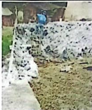
IMAGEM 02: Execução de Muro de arrimo
