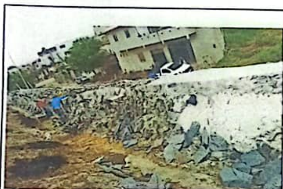
IMAGEM 03: Execução de Muro de arrimo
