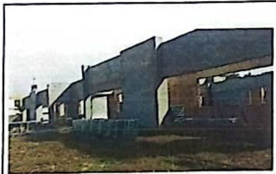
IMAGEM 11: Execução de reboco e emboço e material da estrutura da cobertura
