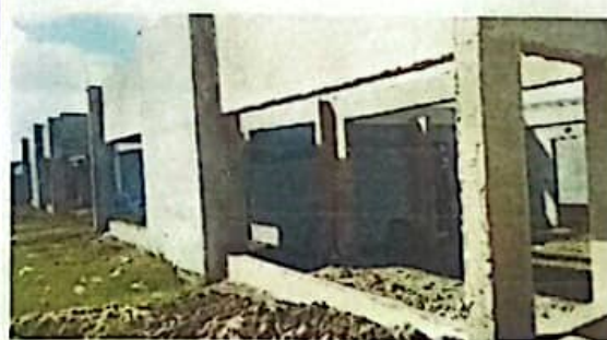
IMAGEM 06: Execução de reboco e emboço
