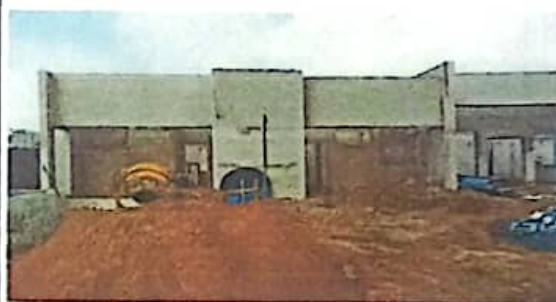
IMAGEM 04: Execução de reboco e emboço
