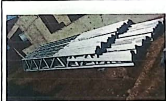
IMAGEM 12: Material da estrutura da cobertura
