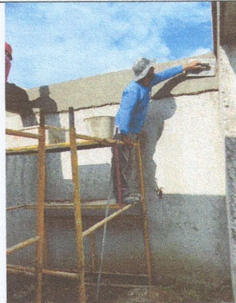
IMAGEM 04: Execução de reboco e emboço
