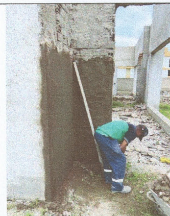
IMAGEM 09: Execução de reboco e emboço
