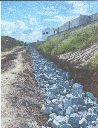
IMAGEM 01: Execução de Muro de arrimo
