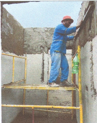
IMAGEM 05: Execução de reboco e emboço
