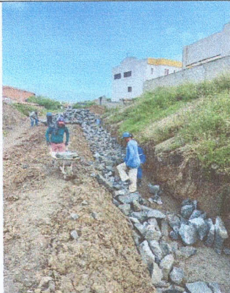
IMAGEM 03: Execução de Muro de arrimo
