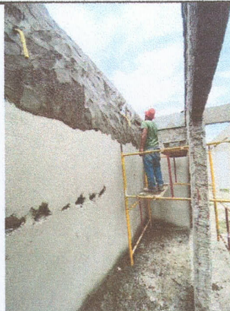
IMAGEM 08: Execução de reboco e emboço
