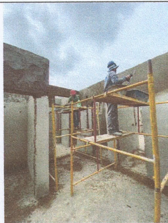
IMAGEM 10: Execução de reboco e emboço
