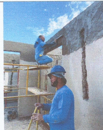
IMAGEM 06: Execução de reboco e emboço
