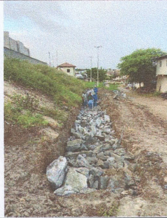
IMAGEM 02: Execução de Muro de arrimo
