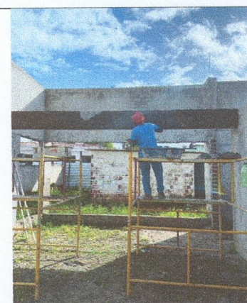
IMAGEM 11: Execução de reboco e emboço
