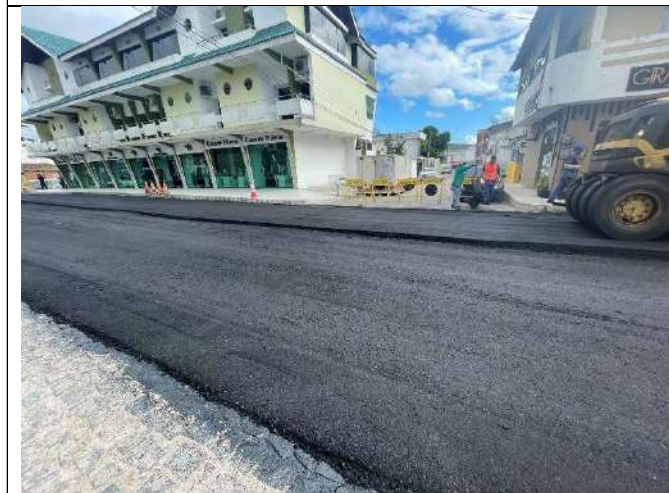
COMPACTAÇÃO DA CAMADA DE ROLAMENTO
