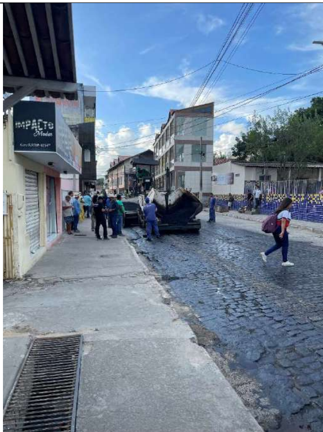
EXECUÇÃO DE IMPRIMAÇÃO
