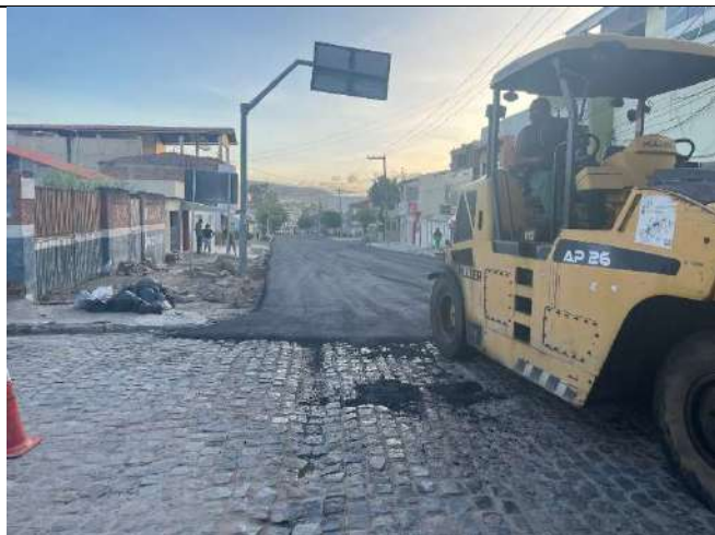
APLICAÇÃO DA CAMADA DE ROLAMENTO
