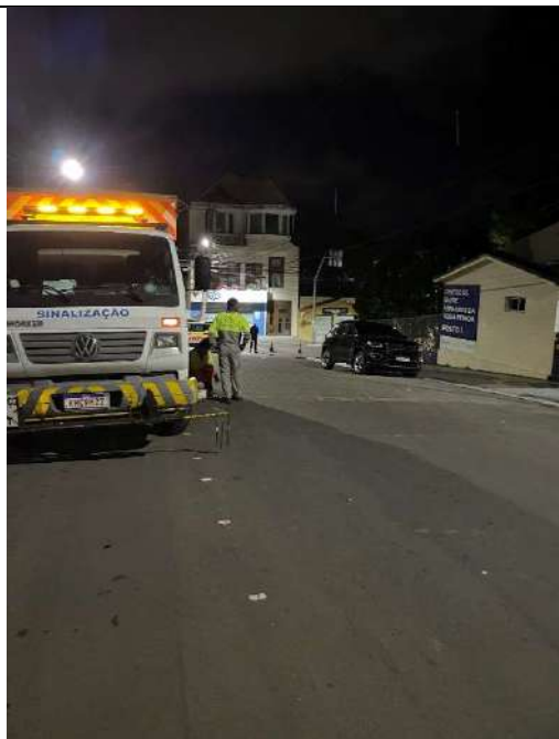
EXECUÇÃO DE SINALIZAÇÃO HORIZONTAL
