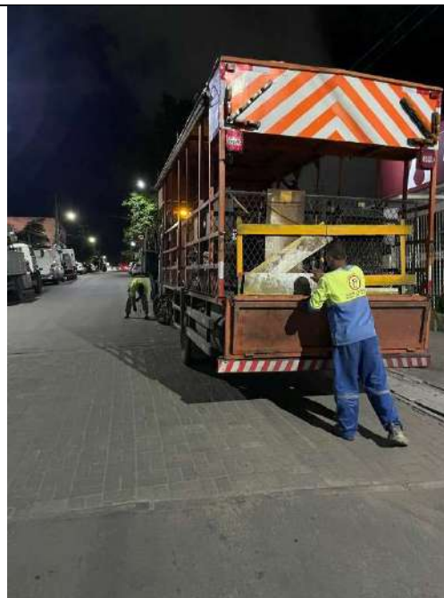
EXECUÇÃO DE SINALIZAÇÃO HORIZONTAL
