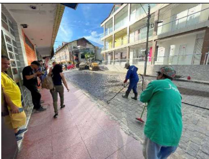
EXECUÇÃO DE IMPRIMAÇÃO
