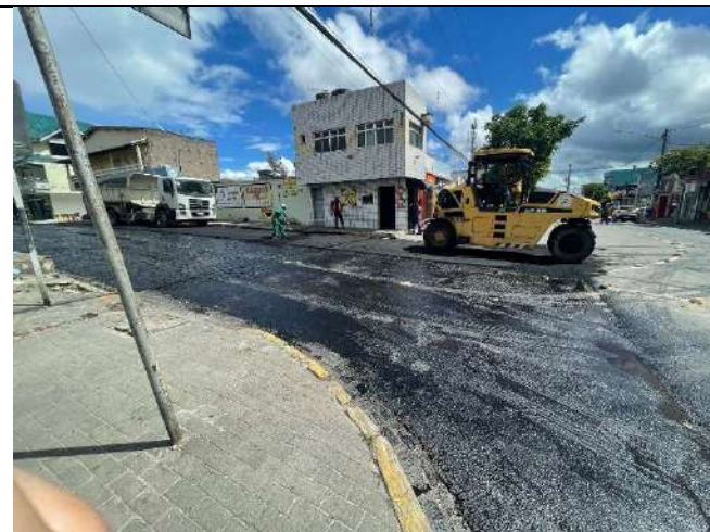
EXECUÇÃO DE IMPRIMAÇÃO
