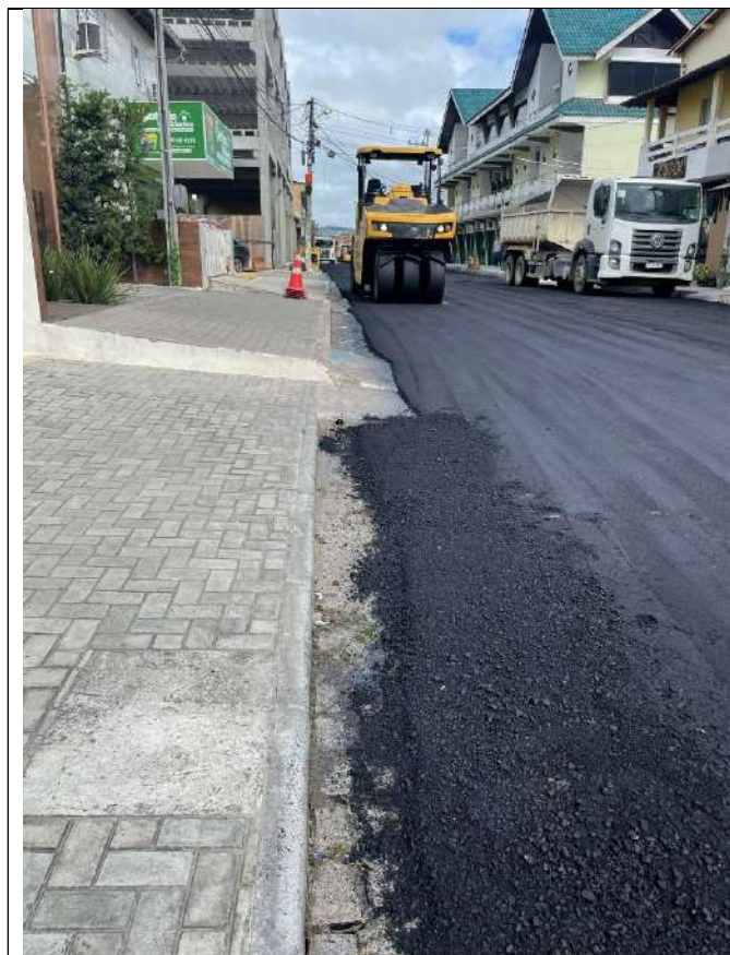
COMPACTAÇÃO DA CAMADA DE ROLAMENTO
