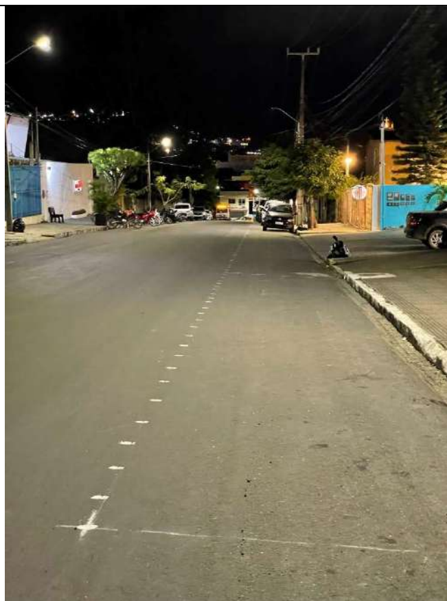
EXECUÇÃO DE SINALIZAÇÃO HORIZONTAL
