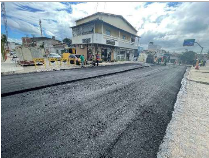
COMPACTAÇÃO DA CAMADA DE ROLAMENTO
