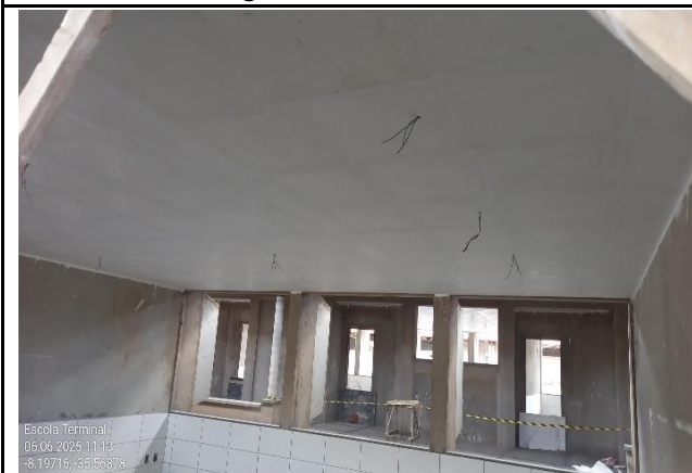
FOTO 17: Forro de gesso do bloco F.
