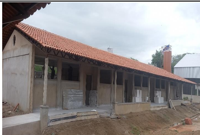
FOTO 01: Coberta com telha ceramica do bloco E1.
