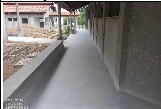
FOTO 11: Piso granilite do bloco C.
