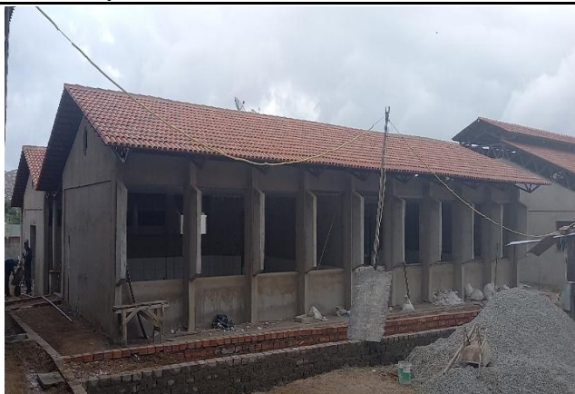
FOTO 02: Coberta com telha ceramica do bloco B.
