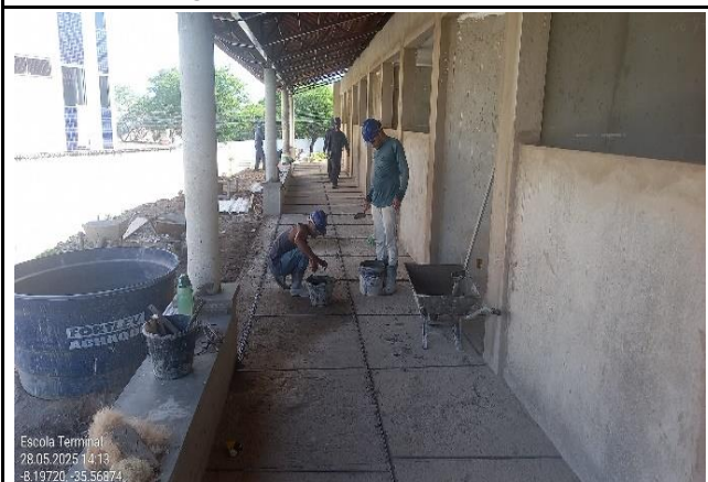
FOTO 09: Piso granilite do bloco F.
