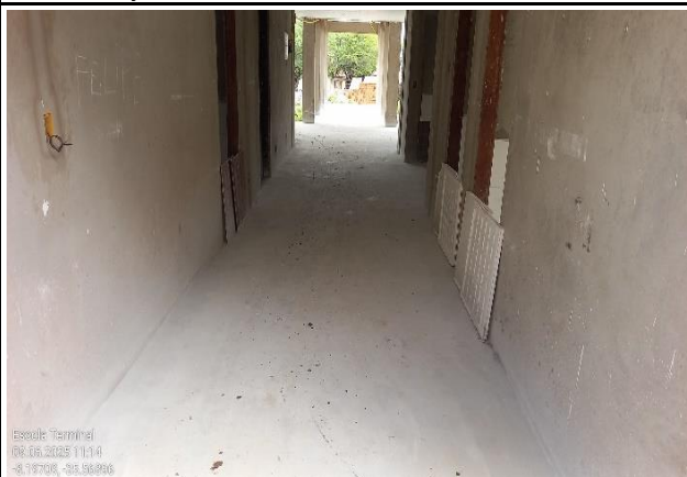
FOTO 08: Piso granilite do bloco A.
