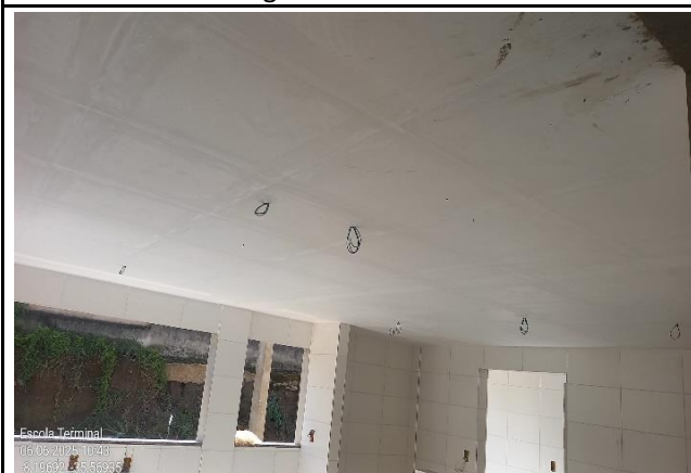
FOTO 15: Forro de gesso do bloco D.
