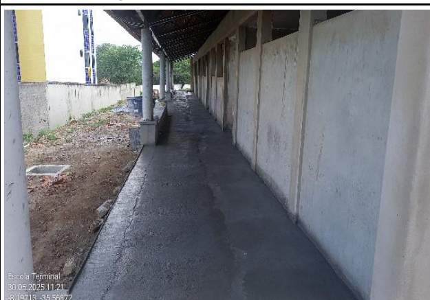
FOTO 10: Piso granilite do bloco F.
