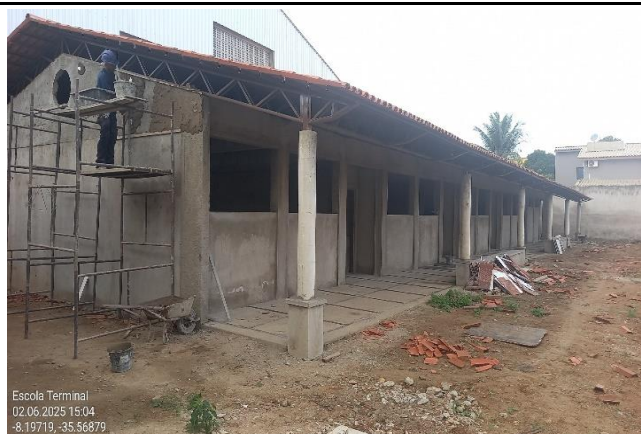
FOTO 03: Coberta com telha ceramica do bloco E2.
