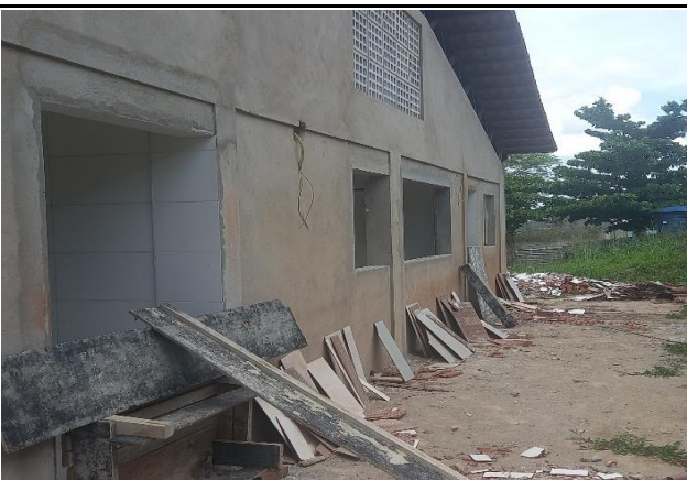
FOTO 06: Capição de pilares, vigas e vão de janelas do bloco D.
