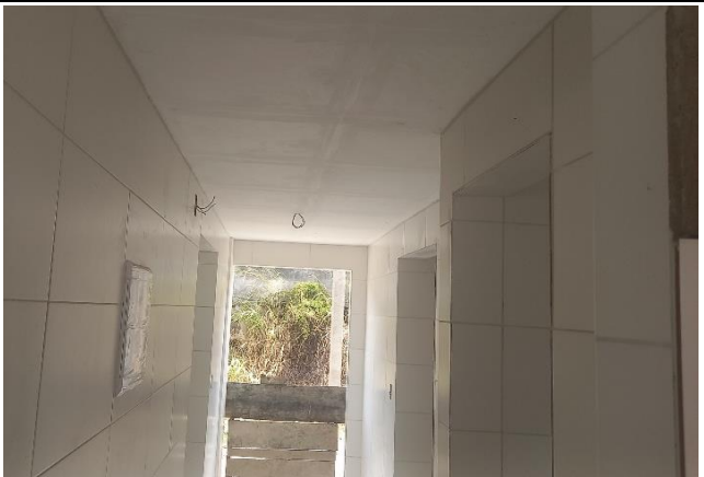
FOTO 10: Revestimento cerâmico das paredes do bloco D.
