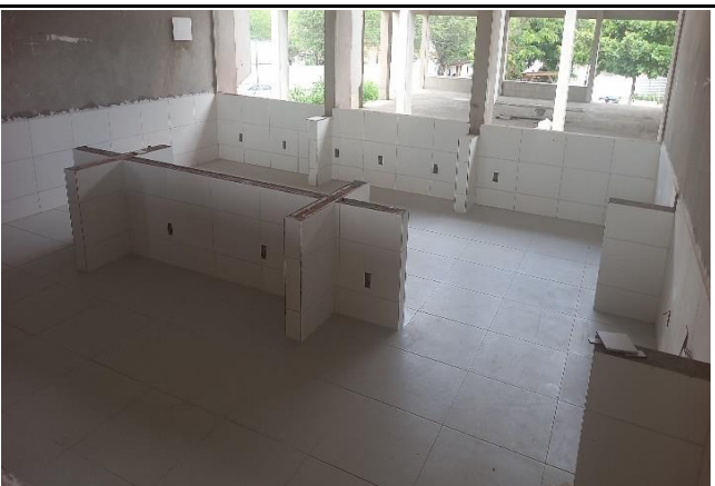
FOTO 12: Revestimento cerâmico das paredes do bloco C.
