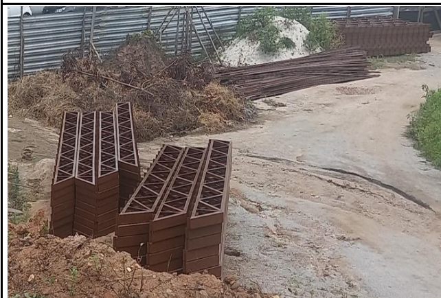
FOTO 17: Estrutura treliçada da cobertura dos blocos.
