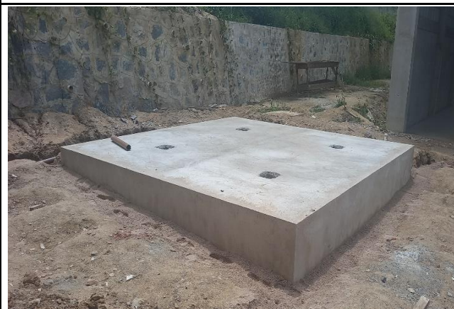
FOTO 03: Concreto da base do reservatório.
