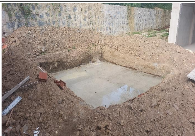
FOTO 02: Concreto magro da base do reservatório.
