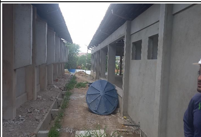
FOTO 05: Capição de pilares, vigas e vão de janelas do bloco C e D.
