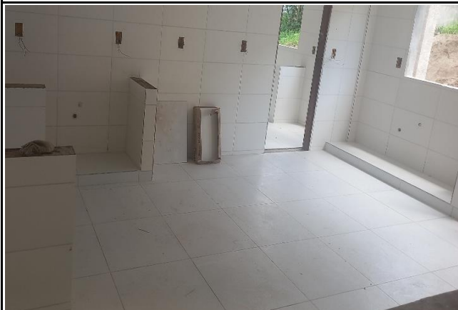
FOTO 13: Revestimento cerâmico do piso do bloco D.
