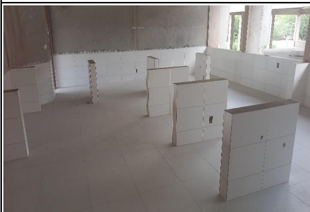
FOTO 11: Revestimento cerâmico das paredes do bloco C.
