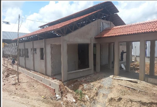
FOTO 07: Capiço de pilares, vigas e vão de janelas do bloco A.
