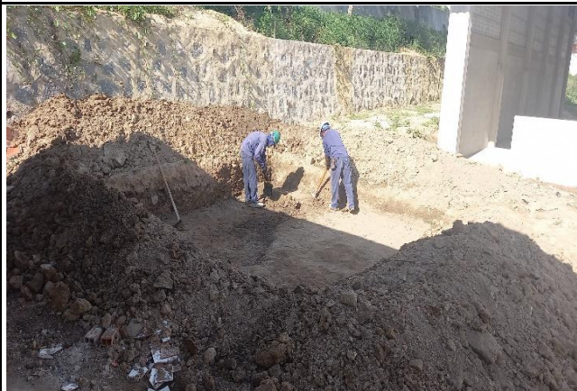
FOTO 01: Escavação da base do reservatório.
