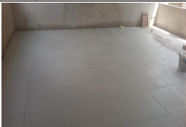
FOTO 14: Revestimento cerâmico do piso do bloco E2.
