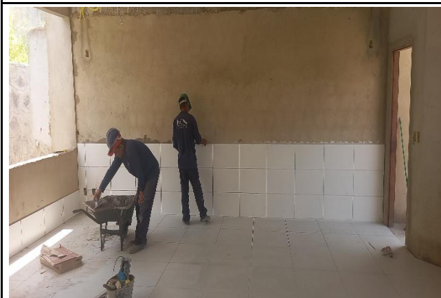
FOTO 15: Revestimento cerâmico do piso e parede do bloco F.
