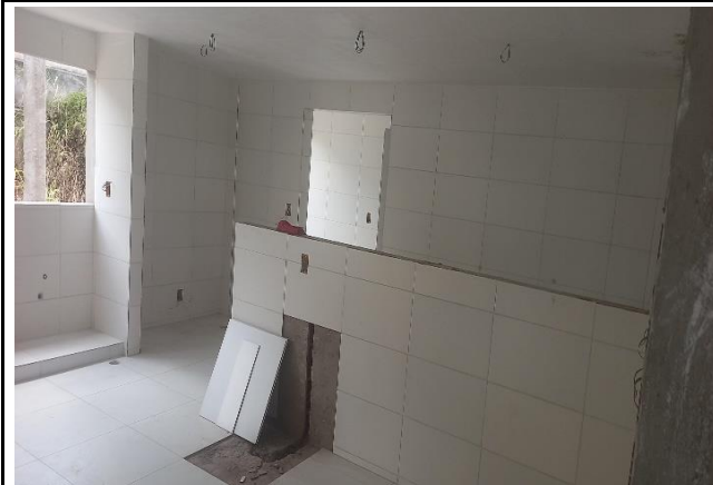
FOTO 09: Revestimento cerâmico das paredes do bloco D.
