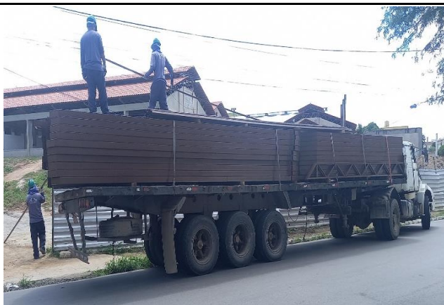
FOTO 18: Estrutura treliçada da cobertura dos blocos.
