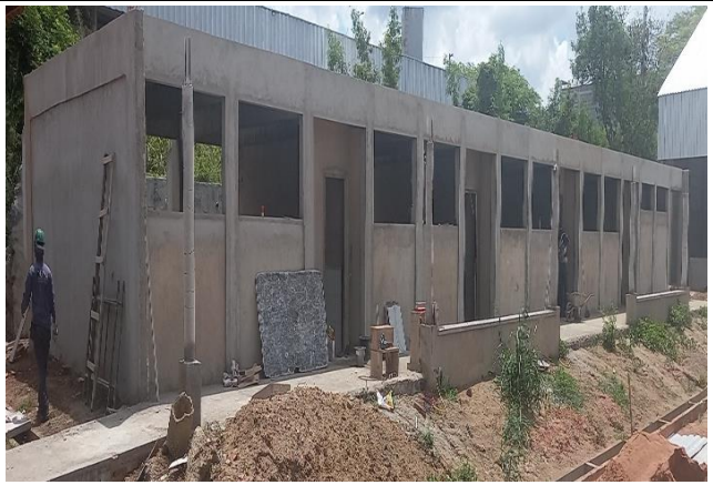
FOTO 08: Capiço de pilares, vigas e vão de janelas do bloco E2.
