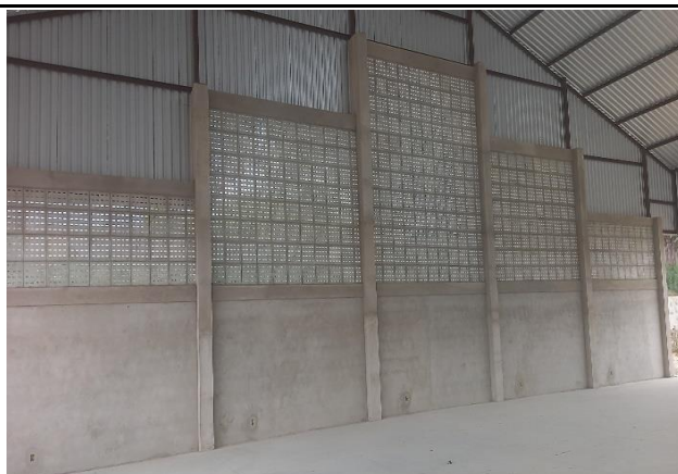
FOTO 04: Capição de pilares e vigas do bloco G.
