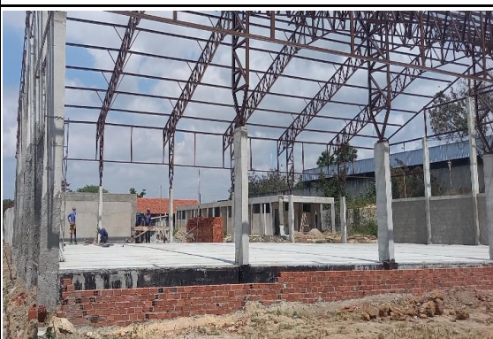
FOTO 06: Alvenaria de embassamento das calçadas laterais da quadra.
