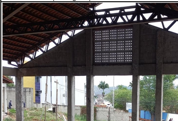
FOTO 11: Cobogó da empena do bloco D.
