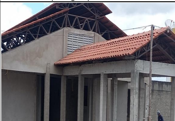
FOTO 12: Cobogó da empena do bloco A.
