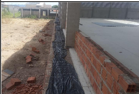
FOTO 05: Lona e ferragem das calçadas laterais da quadra.
