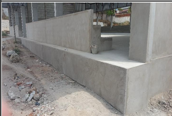
FOTO 07: Reboco do embassamento da calçada lateral da quadra.
