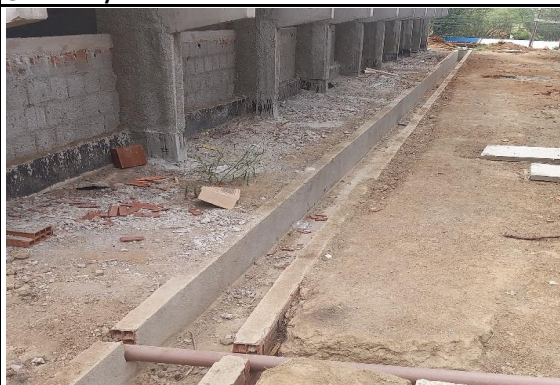
FOTO 10: Calha para águas pluviais.
