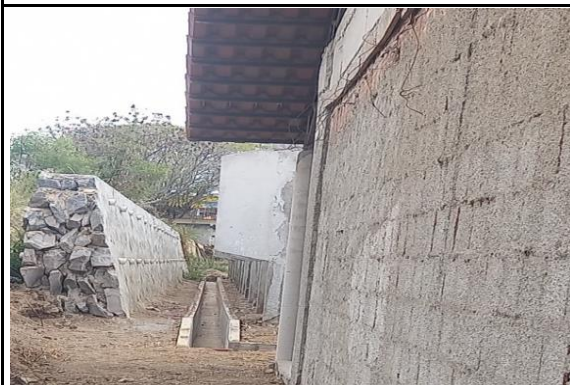
FOTO 09: Calha para águas pluviais.
