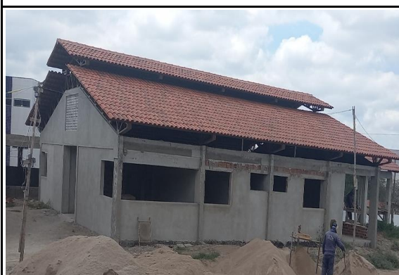
FOTO 03: Reboco externo do bloco A.
