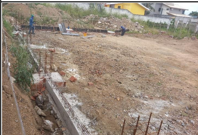
FOTO 09: Fundação do bloco G.
