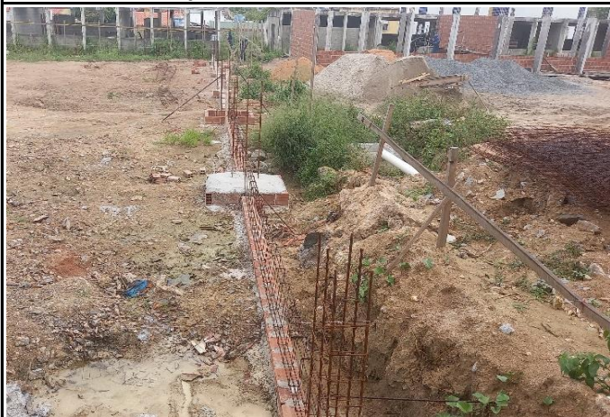
FOTO 11: Fundação do bloco G.
