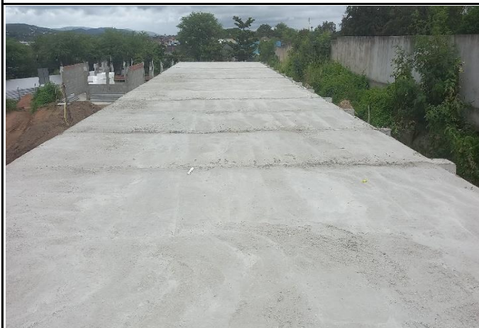
FOTO 03: Laje do bloco E1.
