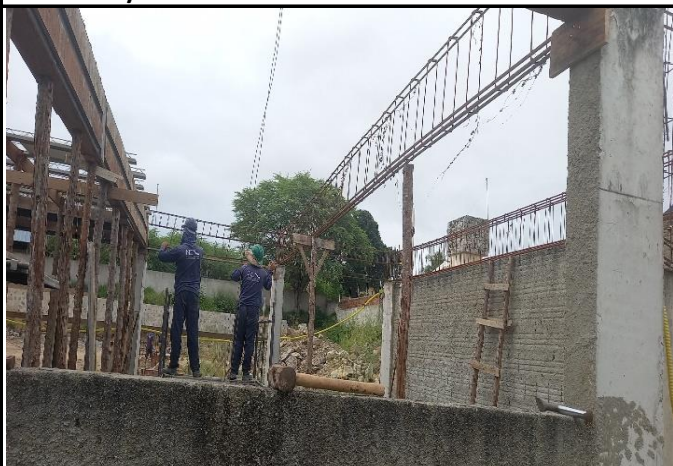
FOTO 02: Vigas do bloco E2.
