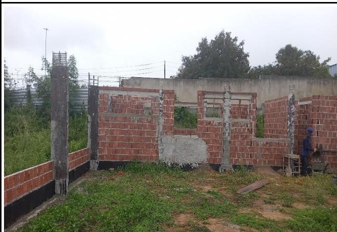
FOTO 04: Alvenaria de vedação do bloco D.
