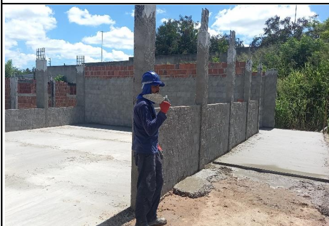
FOTO 05: Alvenaria de vedação do bloco C.
