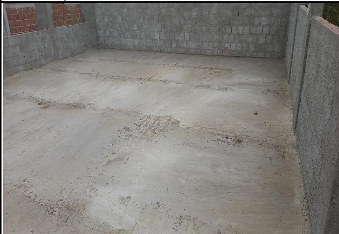
FOTO 08: Contra piso do bloco C.
