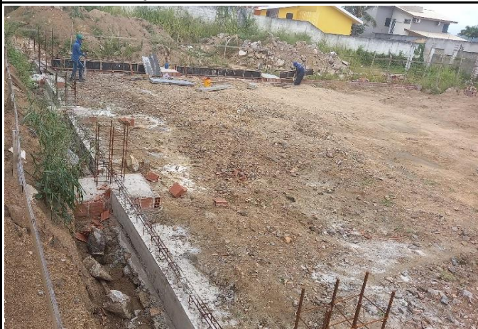
FOTO 12: Fundação do bloco G.
