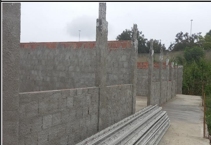
FOTO 07: Chapisco de alvenaria de vedação do bloco C.
