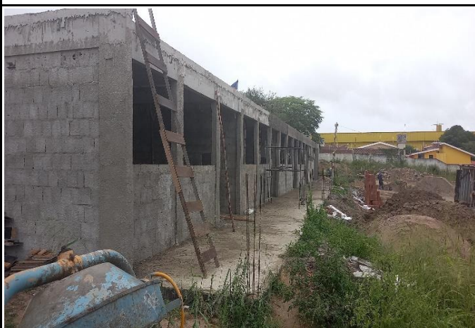
FOTO 06: Chapisco de alvenaria de vedação do bloco E1.
