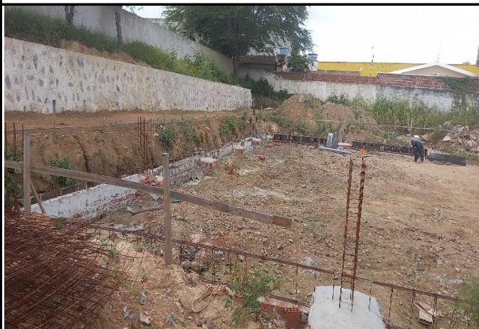
FOTO 10: Fundação do bloco G.
