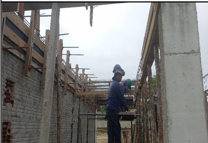
FOTO 01: Vigas do bloco E2.
