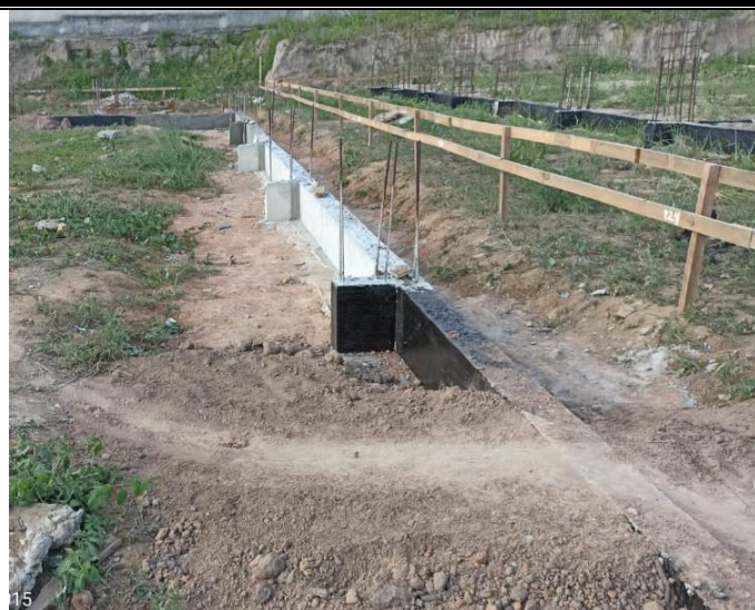
LOCAÇÃO DA OBRA
