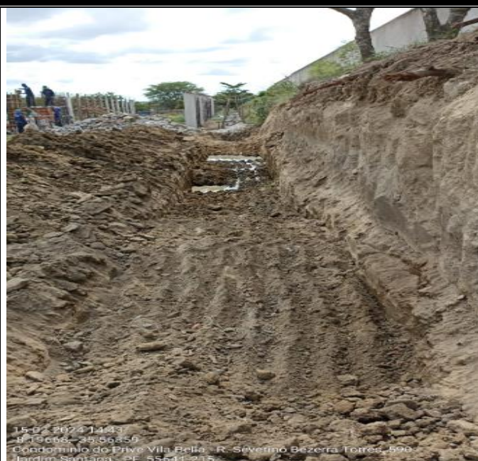
REPARO FUNDO DE VALA
