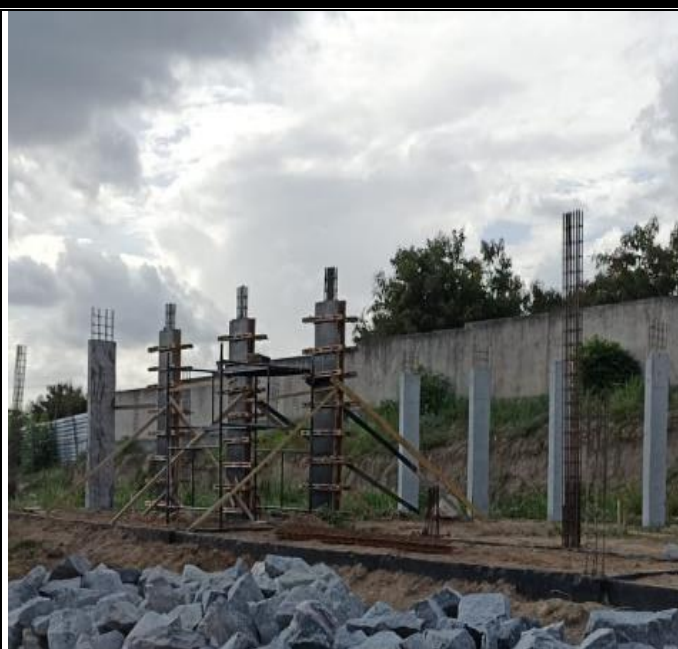
FORMA, CONCRETO E ARMAÇÃO DE PILAR
